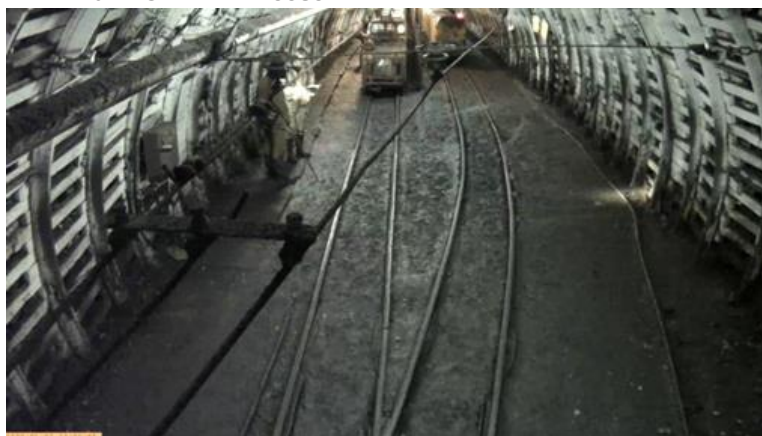
Вид с чамеры в подземной части шахты
