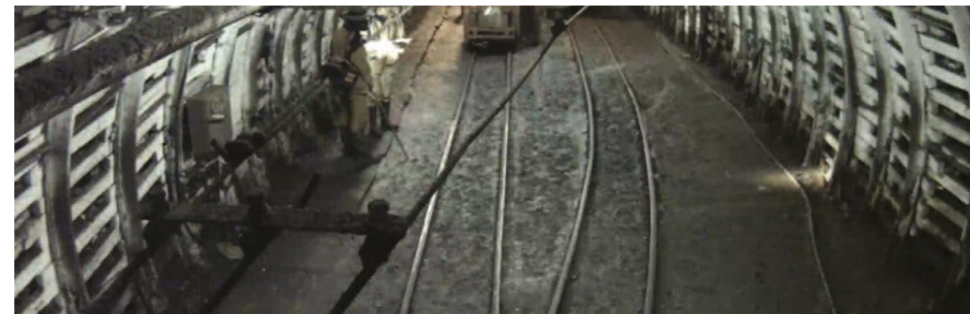
Вид с камеры в подземной части шахты
