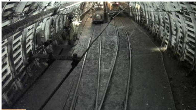
Вид с камеры в подземной части шахты
