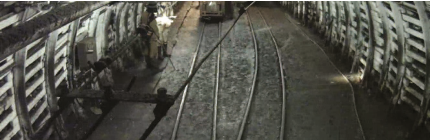
Widok z kamery na dole w kopalni
