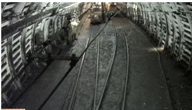
Вид с камеры в подземной части шахты
